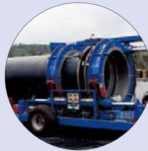
Soldadura de un portabridas sobre un tubo de 1400 mm (Reykjavik, Islandia 2001)
