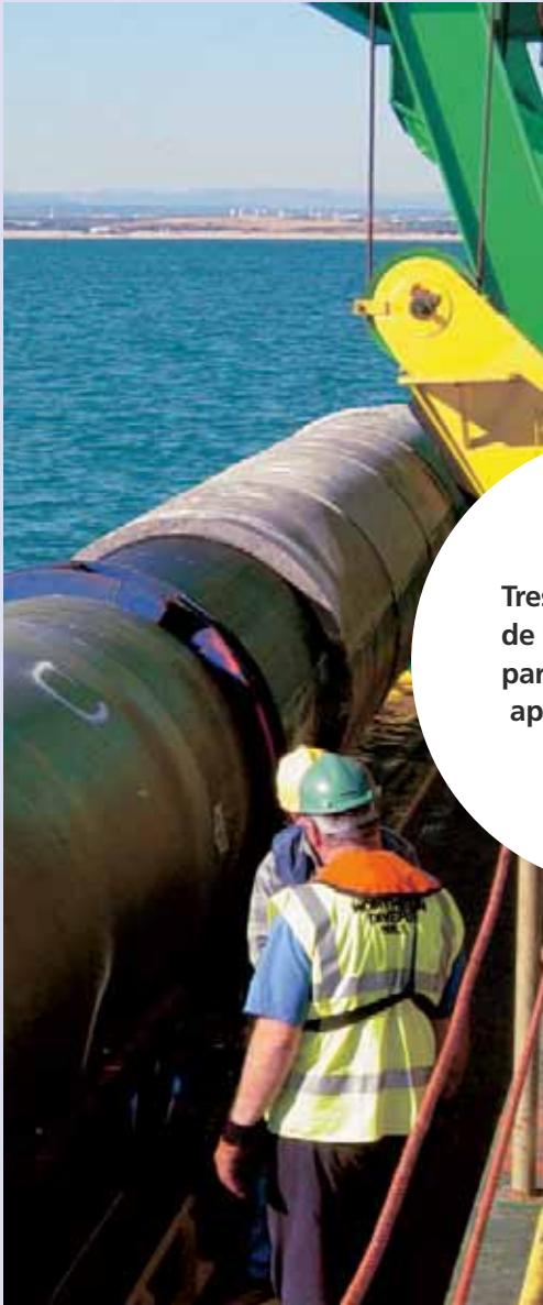
Conexión de acoplamiento GRP e inmersión de la tubería para emisario de PE, de Ø 1600 mm en Montpellier, Francia, 2003
