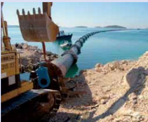
Inmersión del primer tramo de 1500 m de un emisario de PE de Ø 1200 mm en Sibenik, Croacia, 2004
