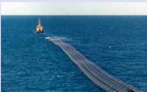
Remolcado de tuberías de Ø 1400 mm en el sur de Islandia, 2001
