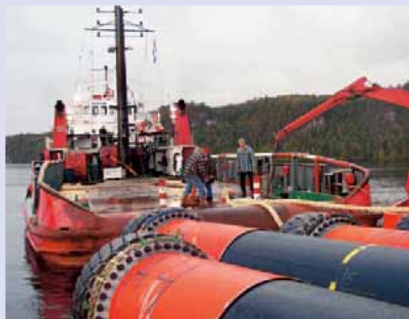
Salida de un remolcador con tubos de 1600 mm (Recife, Brasil 2002)
