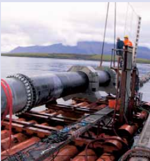
Conexión de dos tramos de tubería ya lastrada, de Ø 1400 mm sobre un pontón, Islandia, 2001
