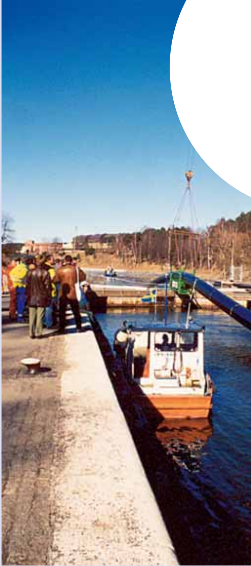
Arrastre de una tubería de PE de Ø 1000 mm en una esclusa en Sdertje, Suecia, 2000
