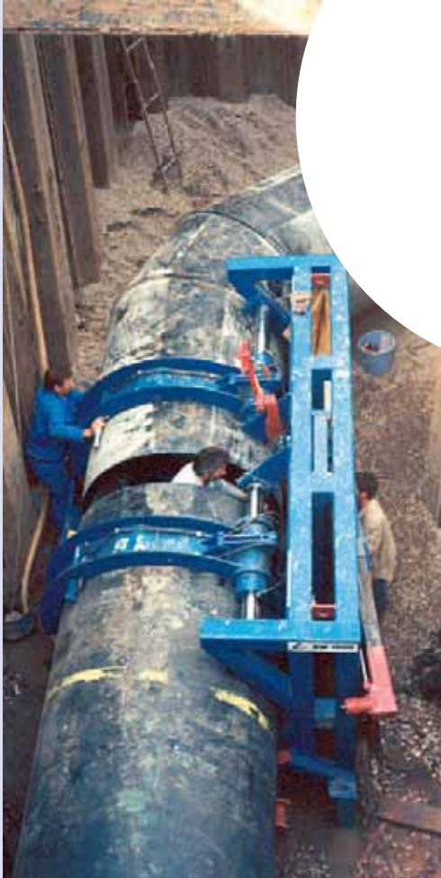
Soldadura del tramo situado en tierra, en el interior de la zanja, tubo de Ø 1600 mm, Antalya, Turquía, 1998
